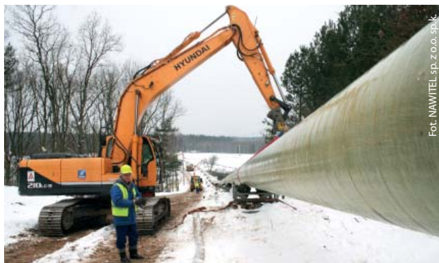
Fot. 3. Wciąganie rury stalowej DN700 – dzień
