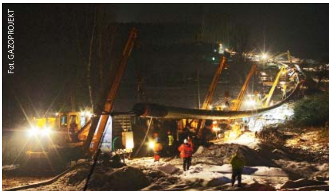
Fot. 4. Wciąganie rury stalowej DN700 – noc
