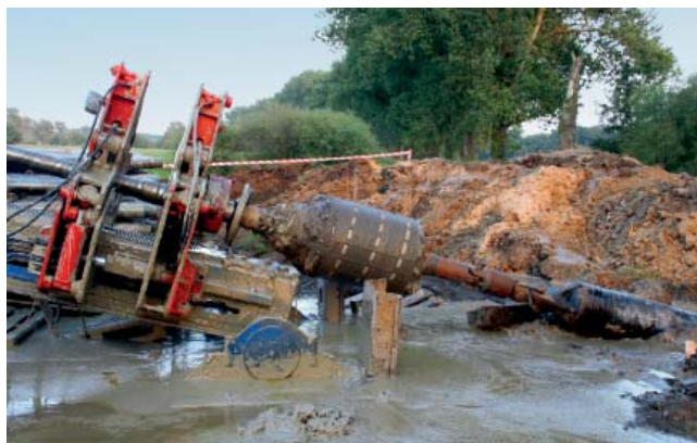
Fot. 3. Moment po zainstalowaniu rur
