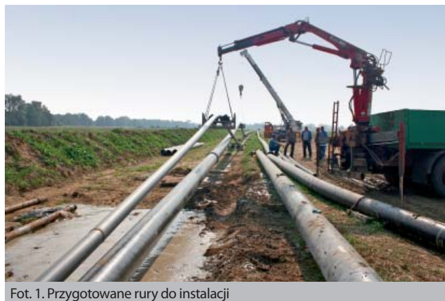
Fot. 1. Przygotowane rury do instalacji
