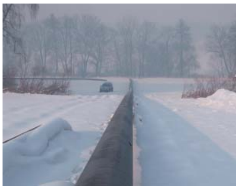
Fot. 3. | Rura przygotowana do wciągnięcia
