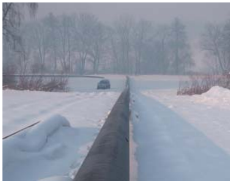
Fot. 3. | Rura przygotowana do wciągnięcia
